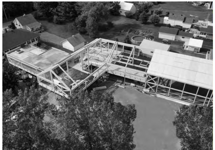
Charpente structurale en bois, août 2022
