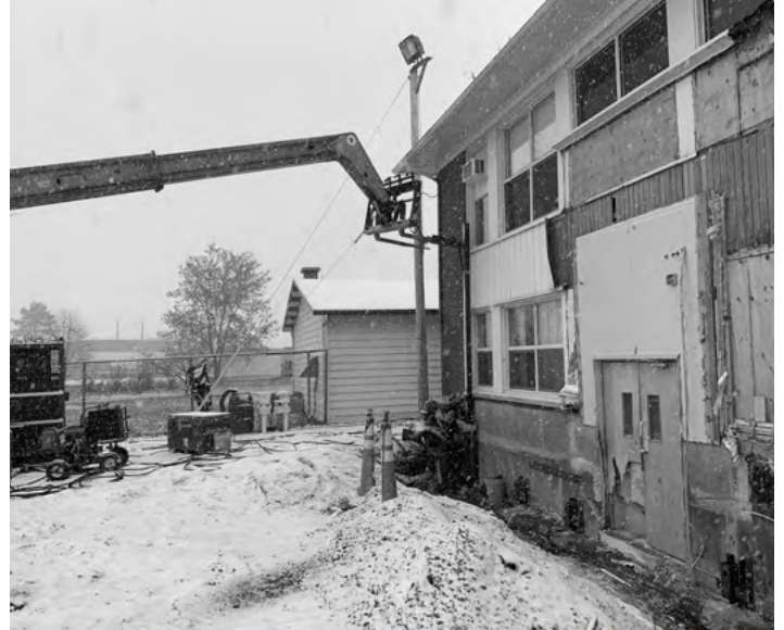
Préparation du site et démolition du gymnase existant, novembre 2021
