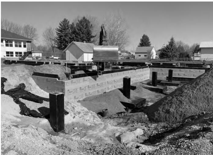
Excavation et fondation, mai 2022
