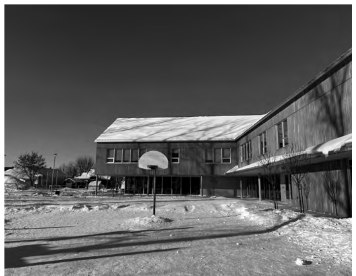
École terminée sous la neige, janvier 2024
