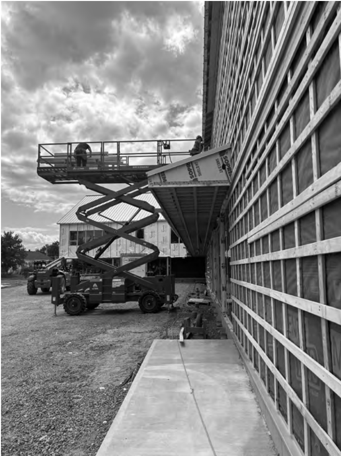
Installation de l'enveloppe de bois et finitions intérieures, juillet 2023
